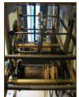
Vue intérieure du mécanisme de clocher Engrenage cylindrique
